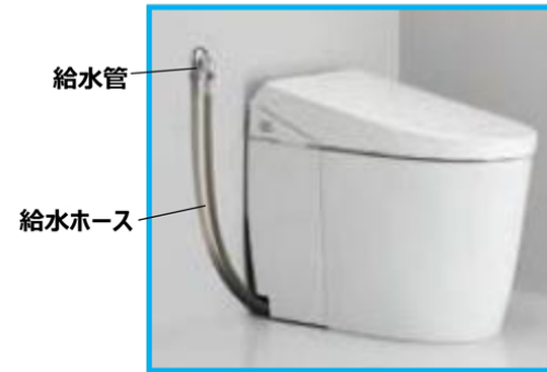
図2 既存の給水管を流用する場合
